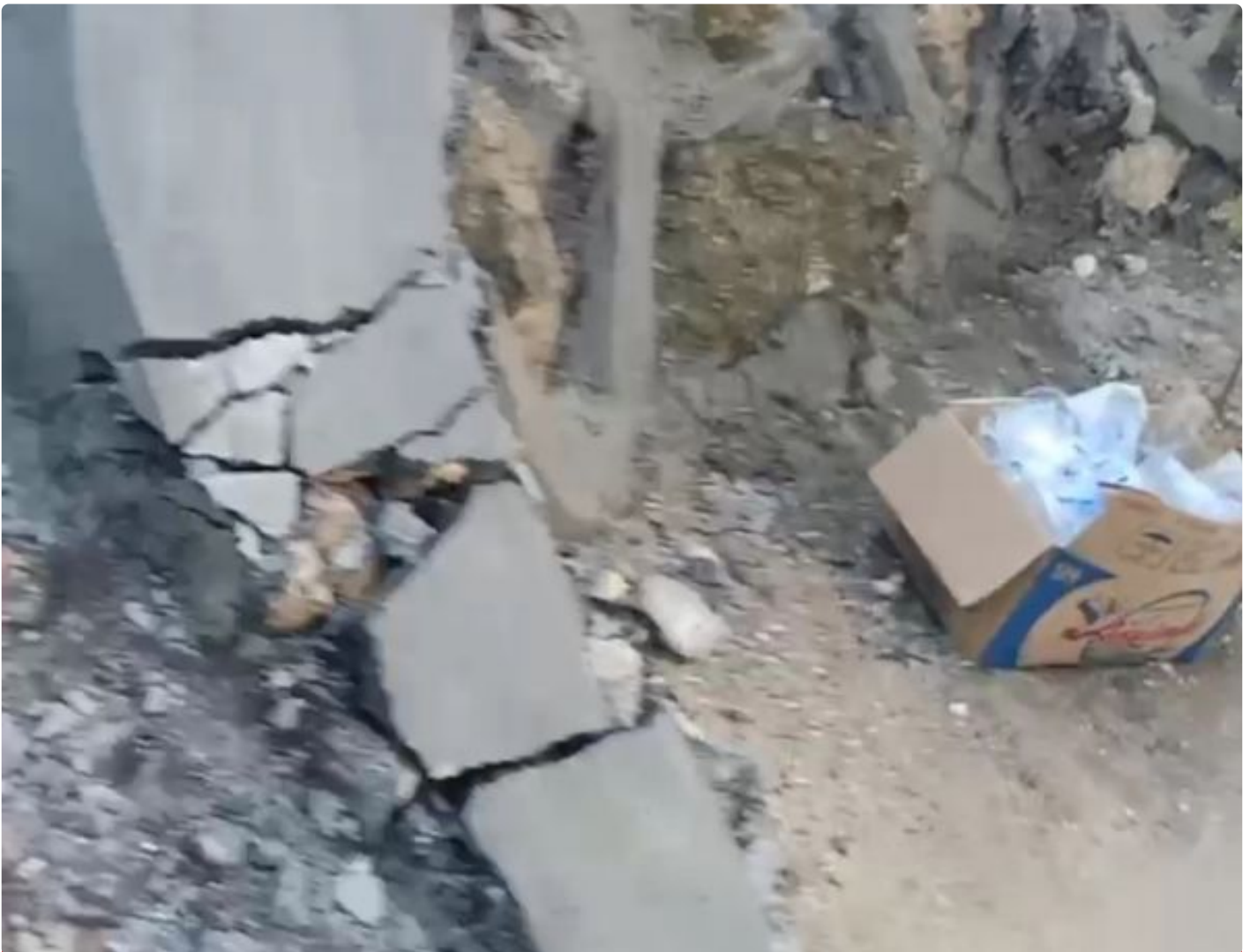
Salah satu bagian Plengsengan yang mulai hancur
